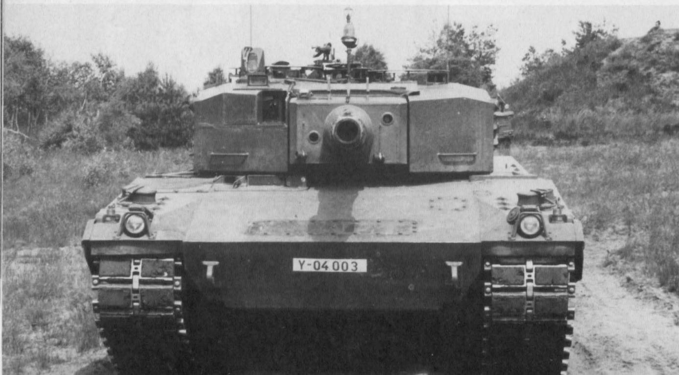
**Der Turm 21** mit der Prototypenwanne PT 20 war ausgerüstet mit der 120 mm Glattrohrkanone und einer Feuerleitanlage der Fa. HUGHES (unteres Bild 1977)
