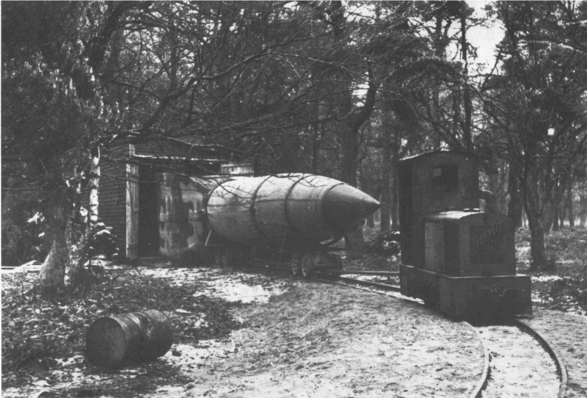
Abholung einer unbetankten A 4-Rakete im abgelegenen Wald-Depot durch Feldbahn. (M)
