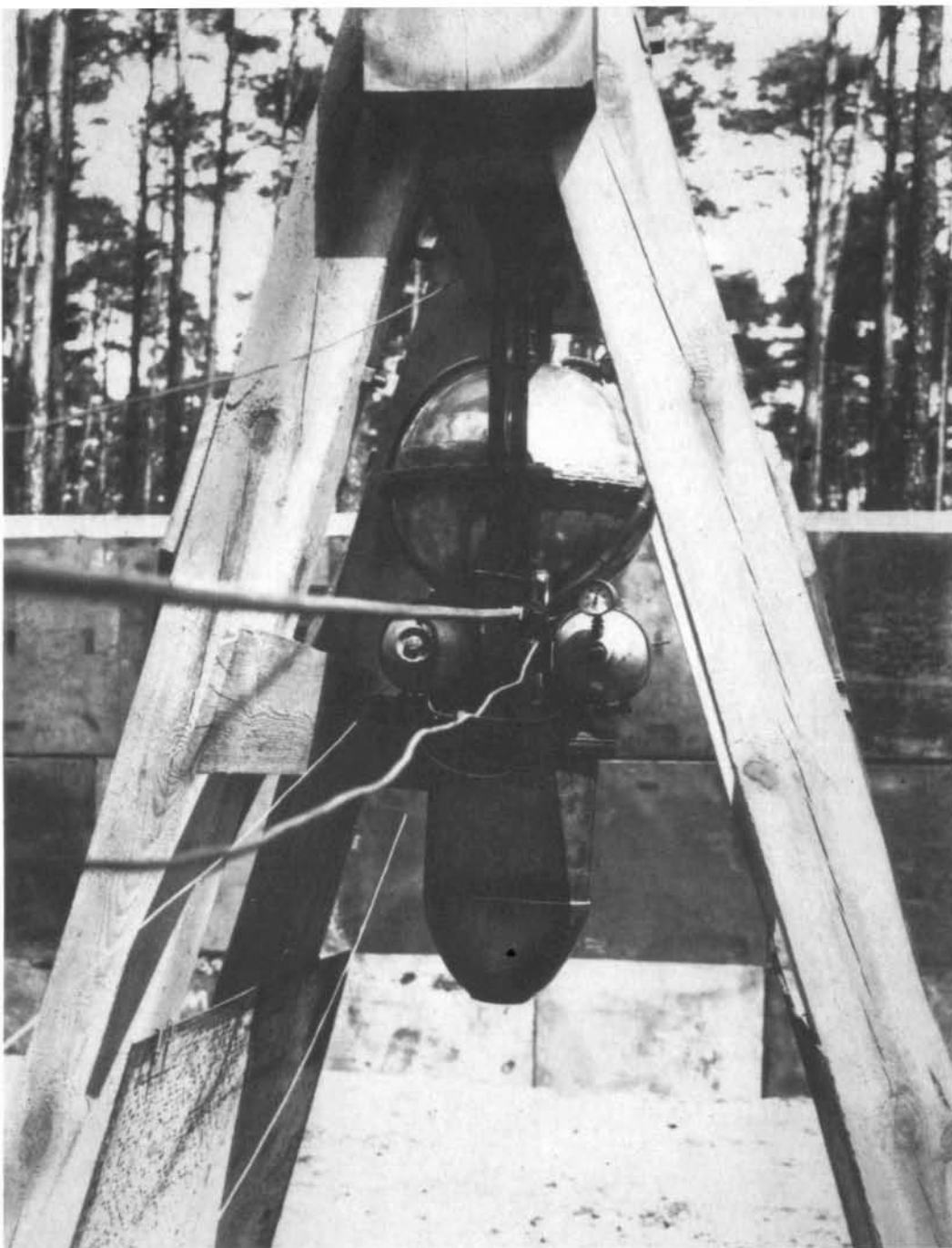
Rudolph's Triebwerk aus Kupfer 1934, ein wichtiger Anfangsschritt. (M)
