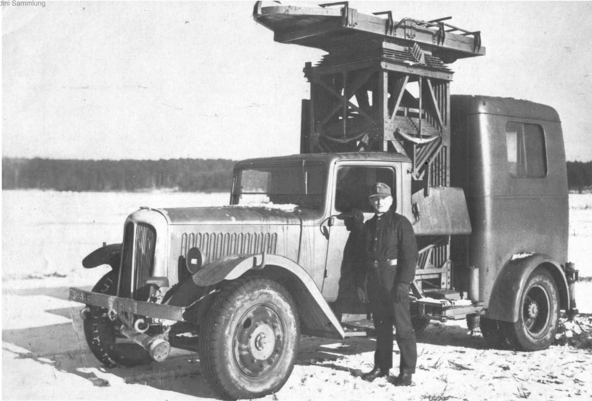
Turmwagen einer FR-Batterie mit hydraulischer Bühne zur weiteren Wartung der senkrecht aufgerichteten Rakete. (M)
