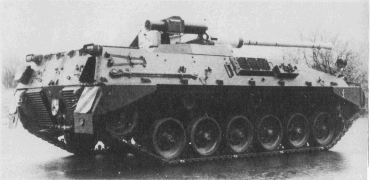
Ältere Versuchsträger unterscheiden sich noch im Heckbereich vom Fahrgestell des SPz MARDER.
