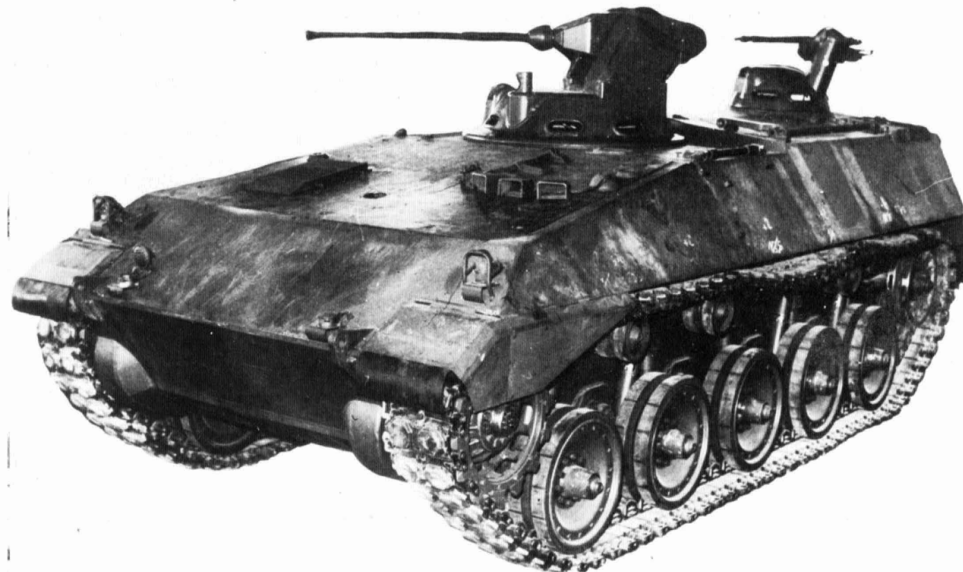
Der Prototyp RU 262, Schützenpanzer — neu der Fa. Hanomag besitzt rein äußerlich schon wesentliche Merkmale des Serienfahrzeugs SPz MARDER, wie z. B. die Scheitellafetten für die 20 mm-Maschinenkanone und für das Heck-Maschinengewehr sowie den Platz für den Triebwerkblok im Fahrzeugbug.
