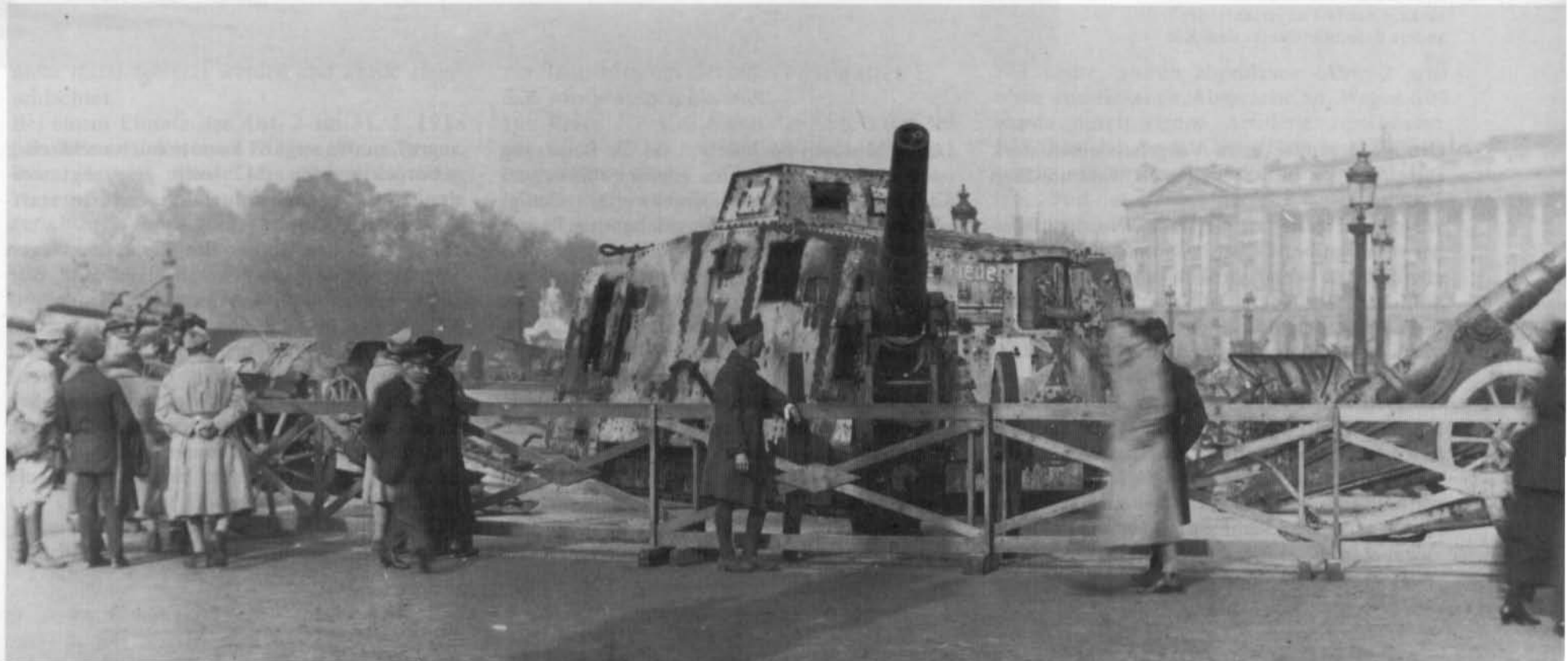
Unten: Nach Ende der Erprobung wurde 542 auf dem Place de la Concorde in Paris ausgestellt. Aus dem Panzer sind Platten für Beschußversuche herausgeschweißt. Aufnahme vom Dezember 1918.
