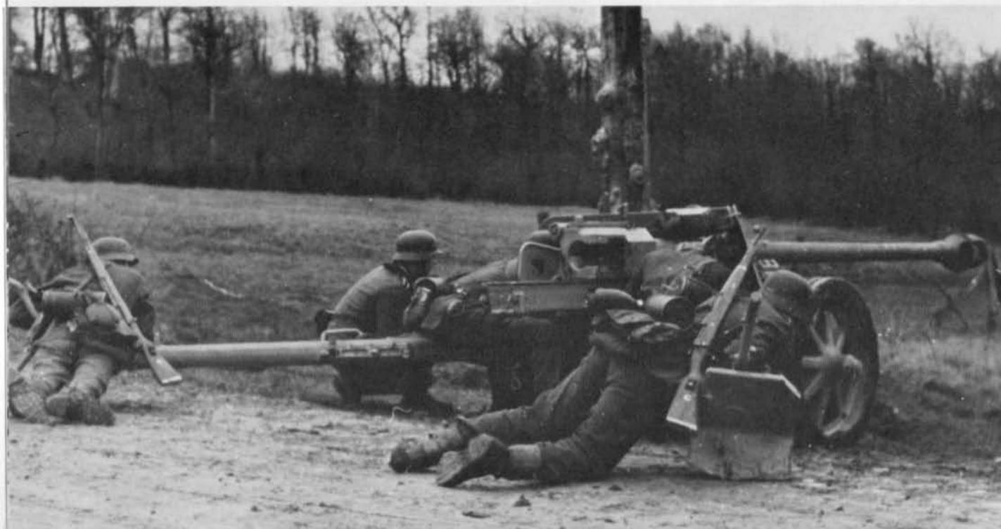
Eine 7,5 cm-Pak in Feuerstellung. Der Geschützführer (ein Unteroffizier) links vom Geschütz, Richt- und der nicht sichtbare Ladeschütze links und rechts dicht hinter dem Schild, Schütze 3 und 4 (rechts) und 5 (links) drücken auf die Holme, um den Rückstoß abzufangen. (BA)
