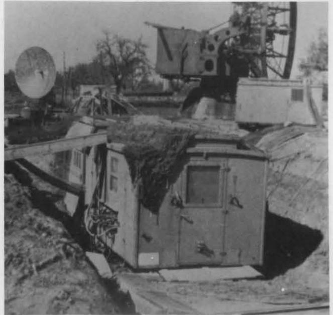
Oben: Im eingegrabenen Bedienungswagen 74/76 "Bayern" waren die Steuervorrichtungen beider FuMG sowie die Anzeigergeräte untergebracht.
