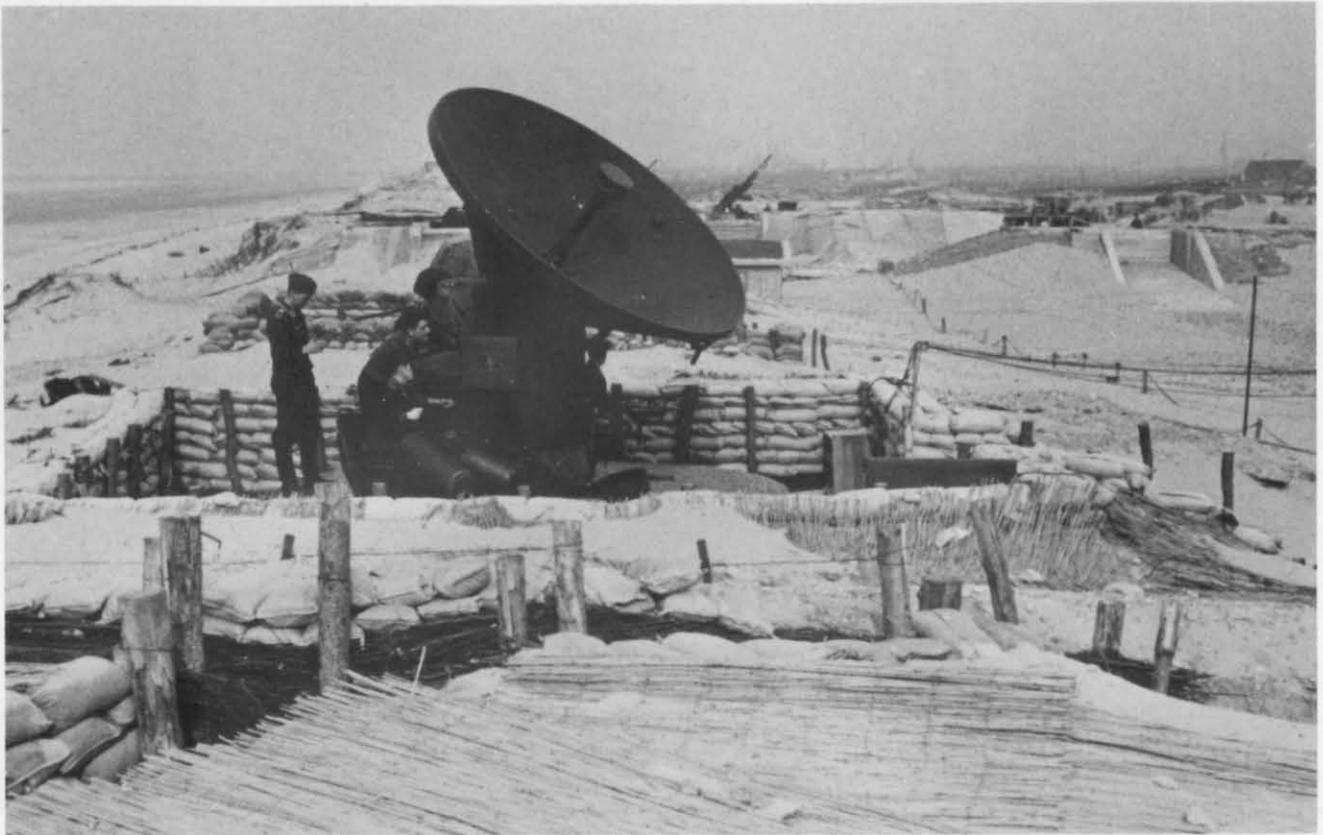
Oben: Dieses FuMG 39 T D steht hier in einer gut ausgebauten 8,8-cm-Flak-Stellung an der Atlantikküste in Frankreich.
