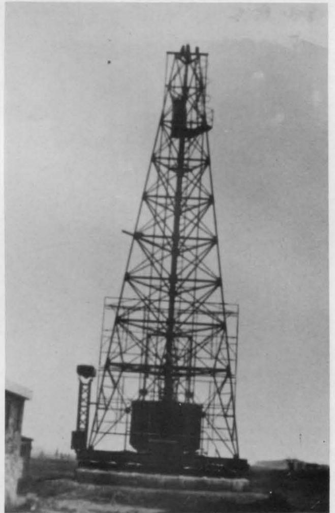
Oben links und rechts: Wir sehen hier die dritte Bauform des "Freya-Fahrstuhls", bei der die Antenne an der Schiene eines 20 m hohen Gittermastes vertikal verschiebbar war.
