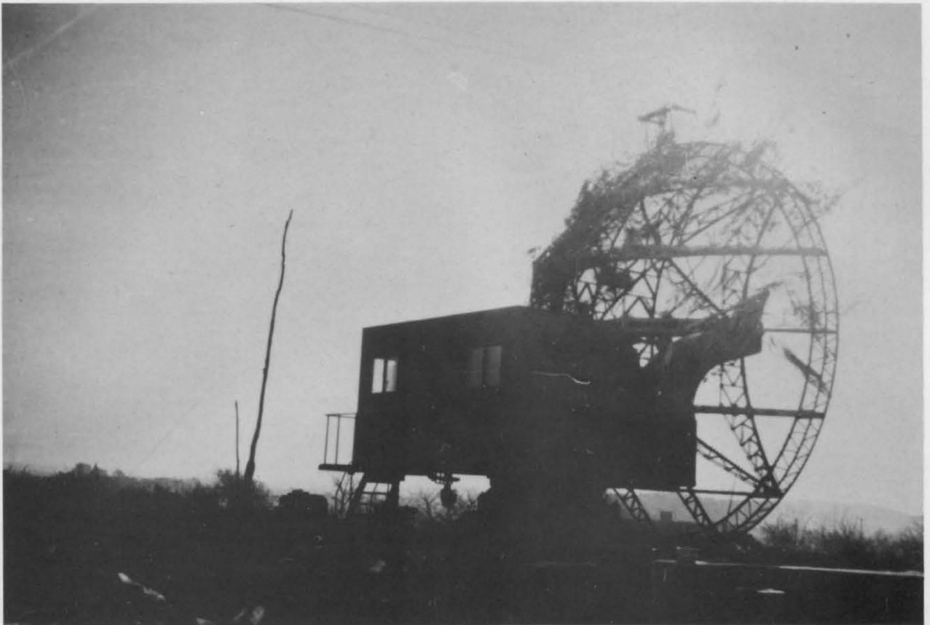
Zwei Bilder eines FuMO "Würzburg-Riesen", so war die Bezeichnung der Marine für das FuMG 65. Dieses Gerät im Bild gehörte zur 3./III. FMA NANTES, bei Saint Servais, oberhalb von La Baule und war zur Bewachung der Küste eingesetzt. Aufgenommen im September 1943.
