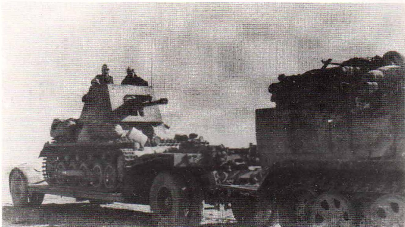
Ein Tiefladeanhänger für Panzertransport (Sd. Ah 115) beim Afrika-Korps. Verladen ist ein Panzerjäger I mit 4,7 cm Pak(t). Fahrgestell ist der Panzer I B.
