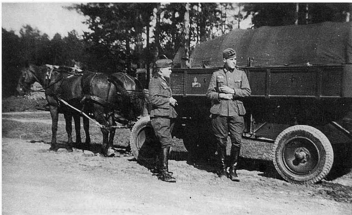
Der Große Gefechtswagen Hf. 7/11 hatte ein Leergewicht von 1,04 t und wog beladen maximal 2,76 t (einschließlich 70 kg Zubehör und zwei Fahrer). Ohne Deichsel war er 4103 mm lang; die Spurweite betrug 1580 mm, der Raddurchmesser 835 mm. Er konnte mit einer Zuggabel an einem LKW angehängt werden.
