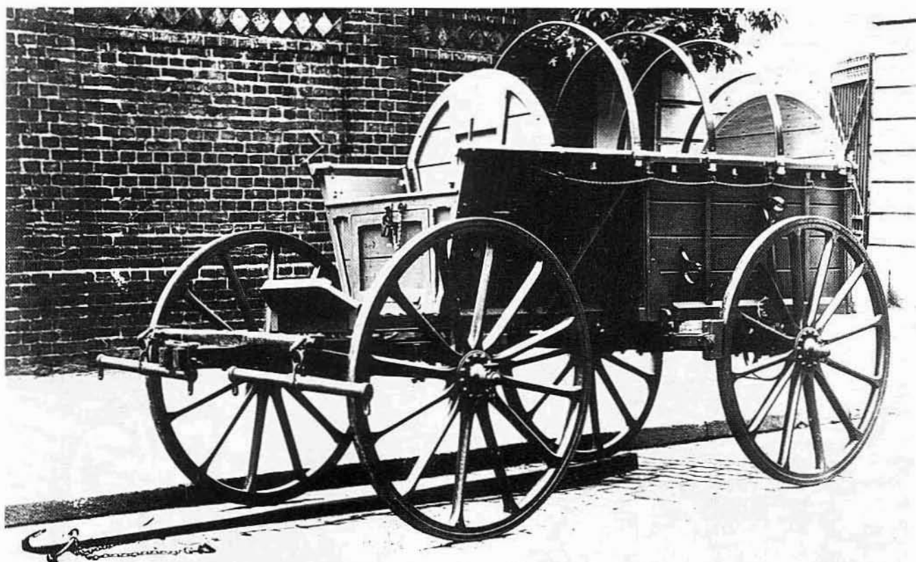
Im Ersten Weltkrieg besonders bewährt hat sich der leichte Feldwagen 95. Er wog leer 0,51 t, war ohne Deichsel 3695 mm lang, 1530 mm breit und 2120 mm hoch (mit Plane).
