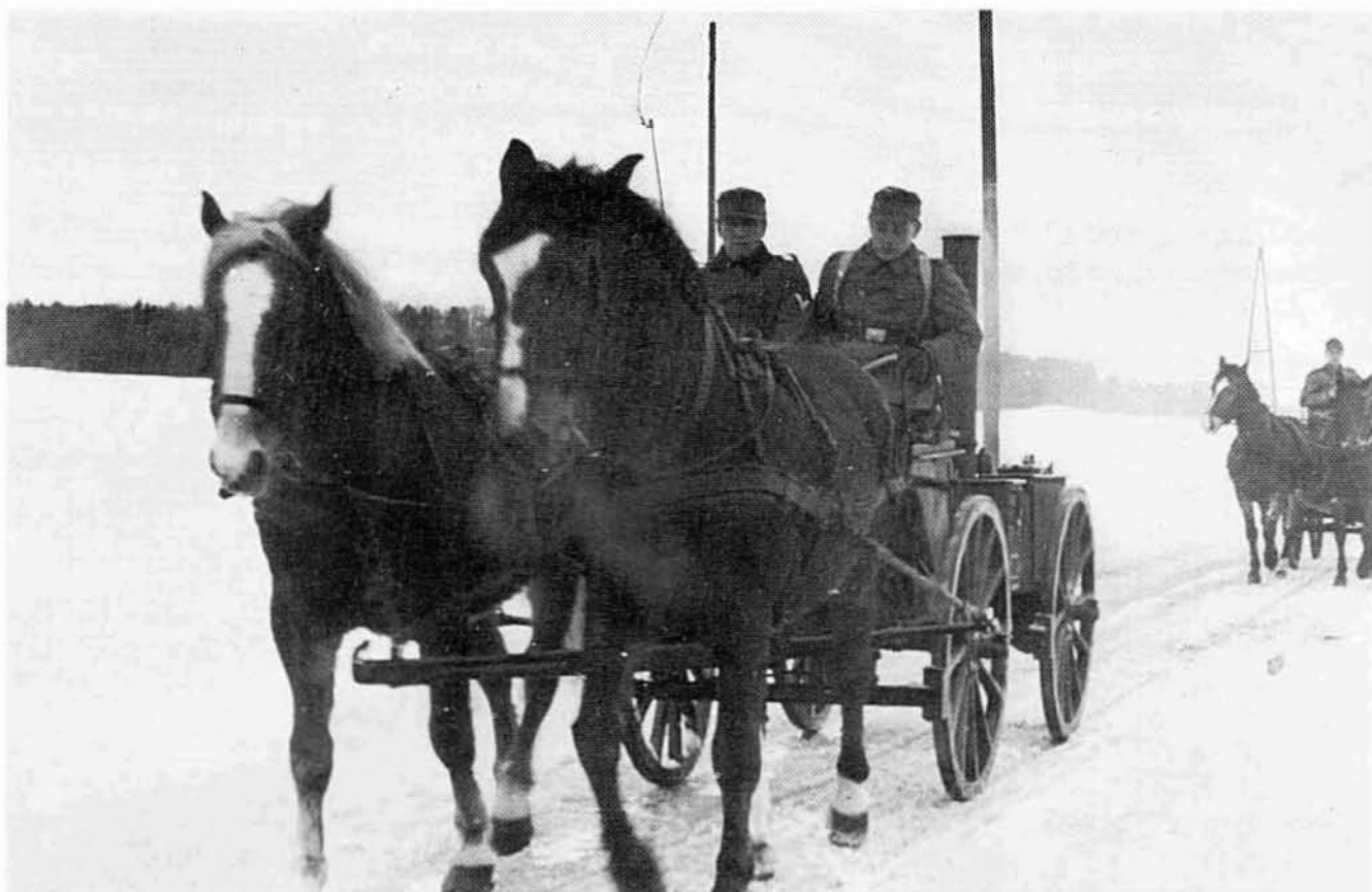
Eine kleine Feldküche beim III./Infanterieregiment 91 im Winter 1939/40 (27. Infanteriedivision). Das Gewicht der Küche lag bei 0,72 t, mit Protze war sie 3410 mm lang und hatte eine Spurweite von 1125 mm. Die kleine Feldküche Hf. 12 wurde auch bei Nachrichteneinheiten, von den Pionieren und anderen Truppen verwendet.
