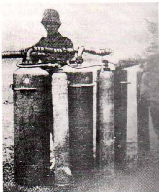
*Drei 100-l-Flammölkessel mit den dazugehörigen Stickstoff-Flaschen werden miteinander verbunden, um die Länge des Flammstoßes zu vergrößern.*
