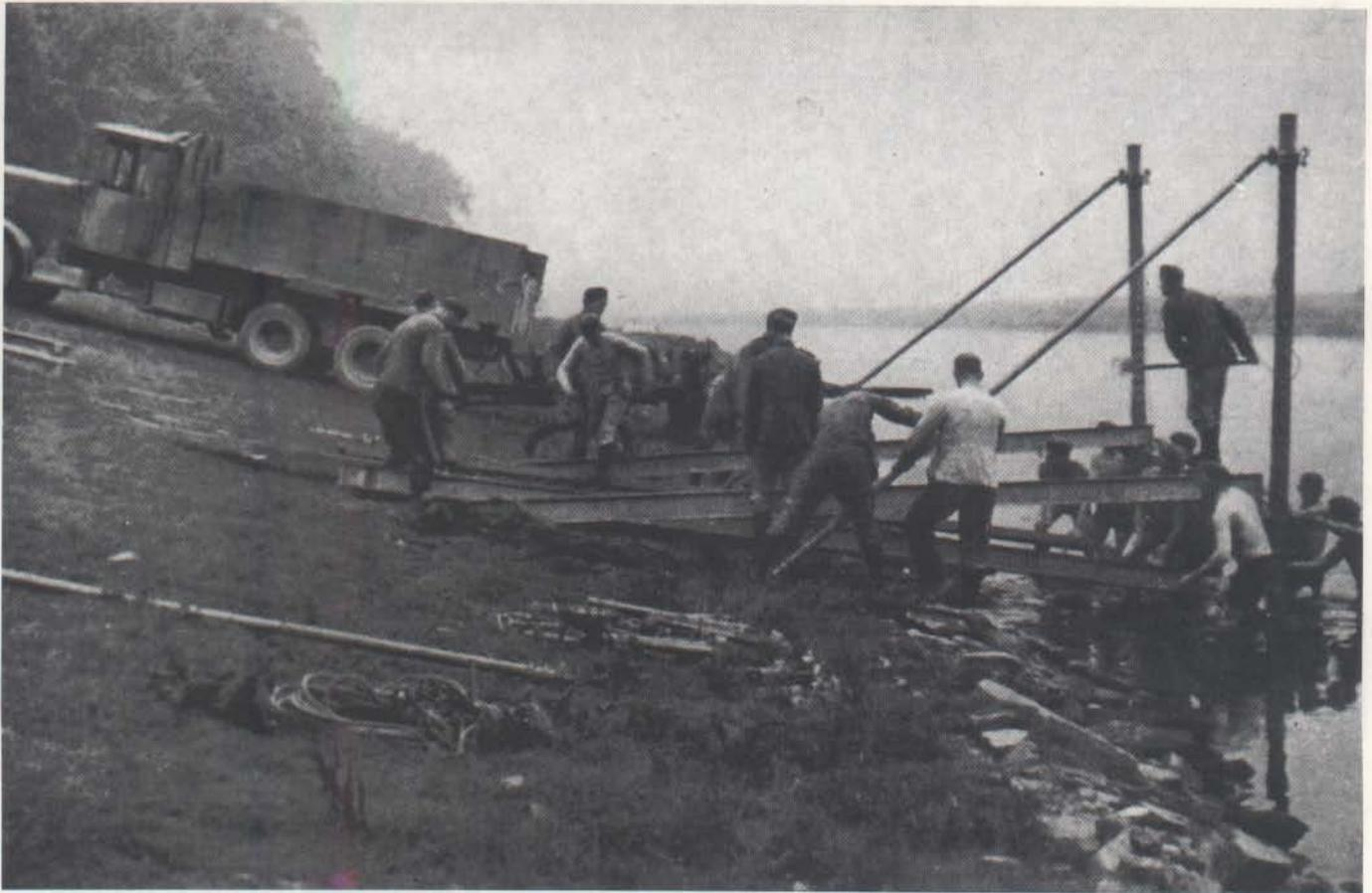
Ein mittlerer geländegängiger Lastkraftwagen 3 to (6x4) Büssing-NAG Typ 3 GL 6 mit angehängtem Sd. Ah. 14. Pioniere sind dabei das Brückengerät abzuladen und für eine Brückenauffahrt zu montieren. (WF)
