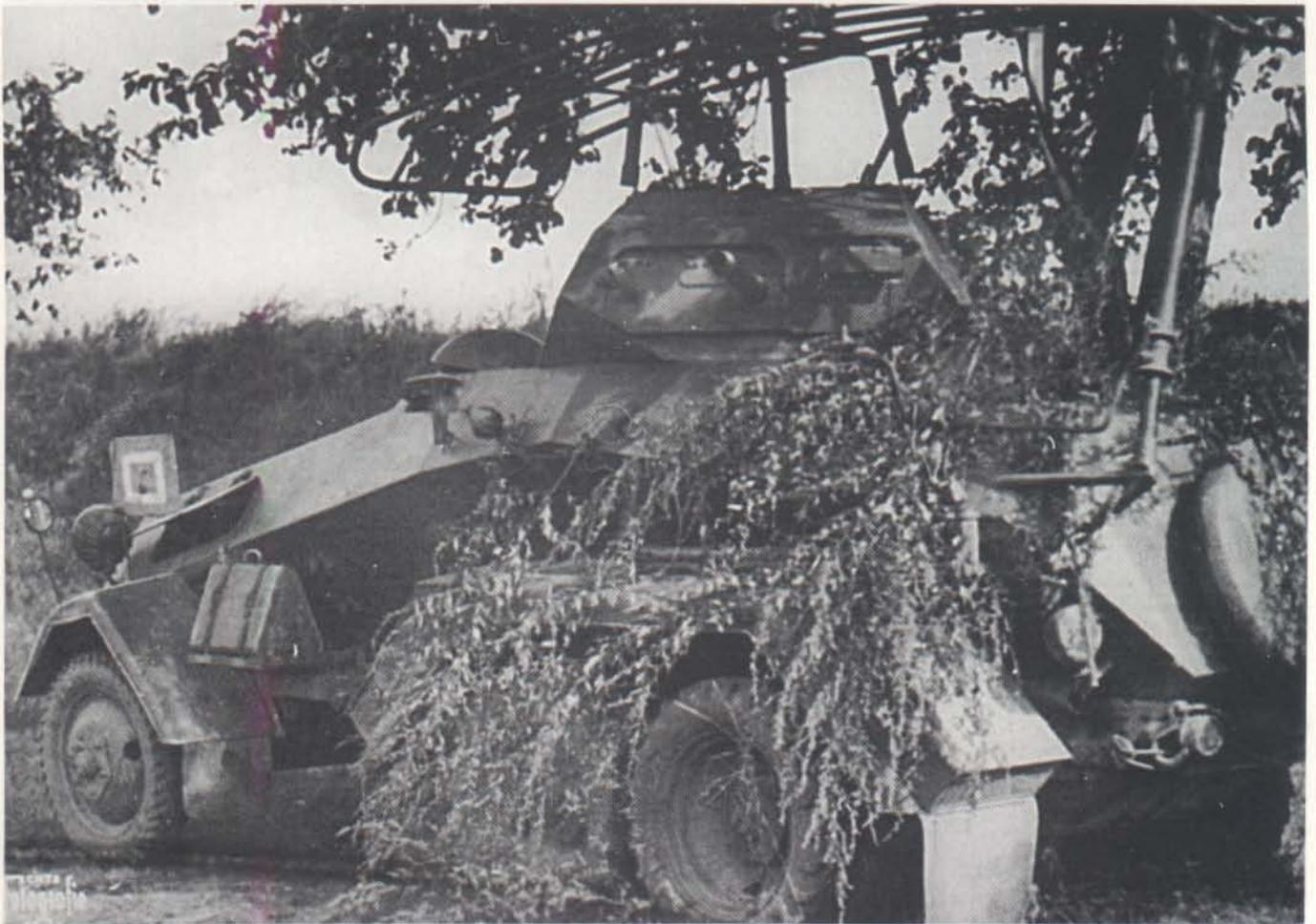
Vom gepanzerten Kraftwagen Kfz. 67 und dem gepanzerten Funkkraftwagen Kfz. 67 a (später Sd. Kfz. 231 und 232) sind zwischen 1930 und 1936 ca. 1000 Stück für die gepanzerte Aufklärungstruppe beschafft worden. Im Bild der gepanzerte Funkkraftwagen Kfz. 67 a. (WF)
