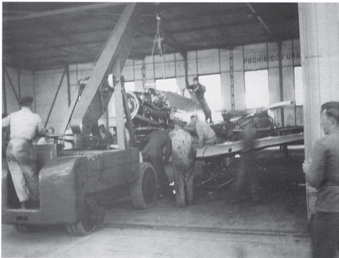
Montage einer He 112 B-0 in Spanien. An der hinteren Hallenwand weist der Satz "Prohibido fumar" auf das bestehende Rauchverbot hin.
