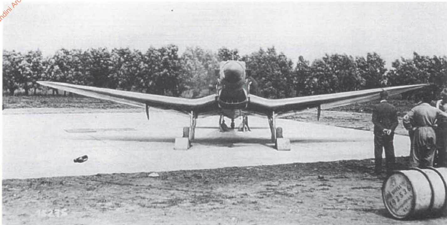
Oben und links: Die He 112 VI D-IADO noch ohne Zierbemalung beim Probelauf des flüssiggeköhlten 12 Zylinder V-Motors von Rolls-Royce.
