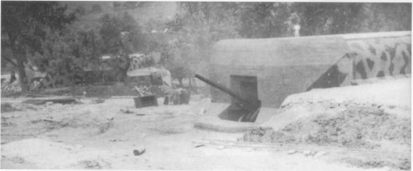
Die lange 10-cm-Kanone in Turmlafette. Bis 1940 kamen nur acht Stück zur Ausfertigung. Die Besatzung wurde durch einen vierteiligen Vorpanzer von 360 t Gewicht zusätzlich geschützt. In dem Panzerturm war außerdem noch ein Maschinengewehr 34 und ein Flammenwerfer zur Nahverteidigung eingebaut.
