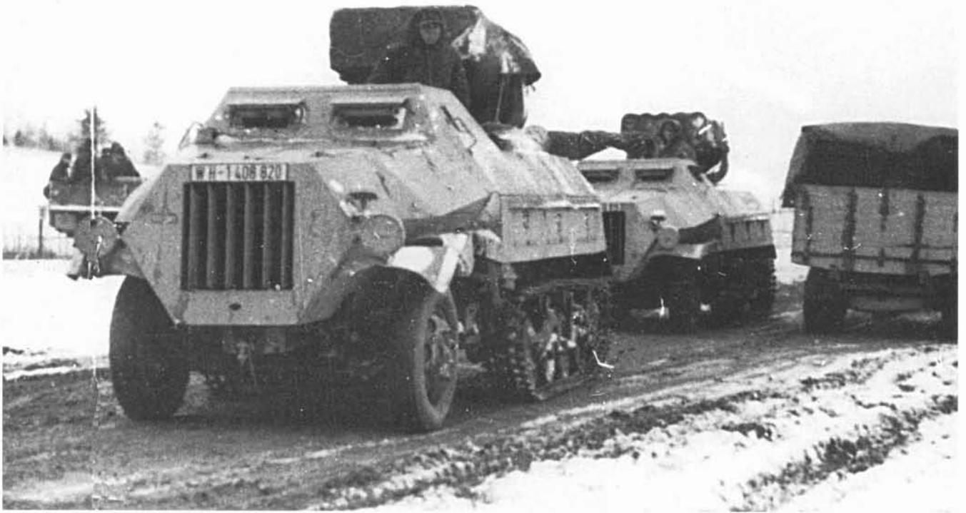
*Die dreiköpfige Besatzung des 15 cm-Panzerwerfers 42 wurde durch eine 6 bis 10 mm dicke Panzerung geschützt. Ein Funksprechgerät gehörte zur Ausrüstung; im Turm befand sich ein Richtaufsatz 35.*
