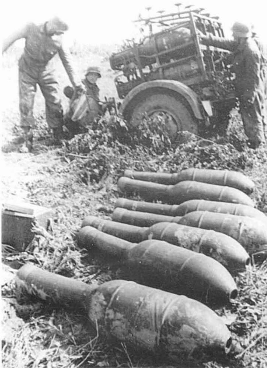
*Die Bedienung bereitet einen 28/32 cm-Nebelwerfer für den Einsatz vor. Wegen zu geringer Schußweite ist die Fertigung dieses Wurfers 1942 wieder eingestellt worden. 1945 befanden sich noch 37 Stück bei der Truppe.*
