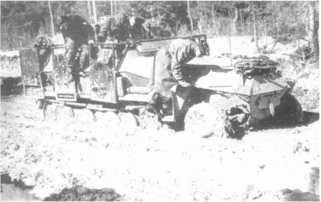
*Ein mittlerer Schützenpanzerwagen HL kl 6 p (Sd. Kfz. 251) mit... dem schweren Wurffrahmen 40 im Frühjahrsschlamm an der Ostfront. An jeder Seite des Fahrzeuges konnten drei Packkisten mit 28 cm-Wurfkörper Spreng oder 32 cm-Wurfkörper Flamm eingehängt und abgeschossen werden. Damit wurde dieses wirksame Kampfmittel sehr beweglich. Im Einsatz waren solche Schützenpanzer bei den Panzerpionierbataillonen zu finden (unten).*
