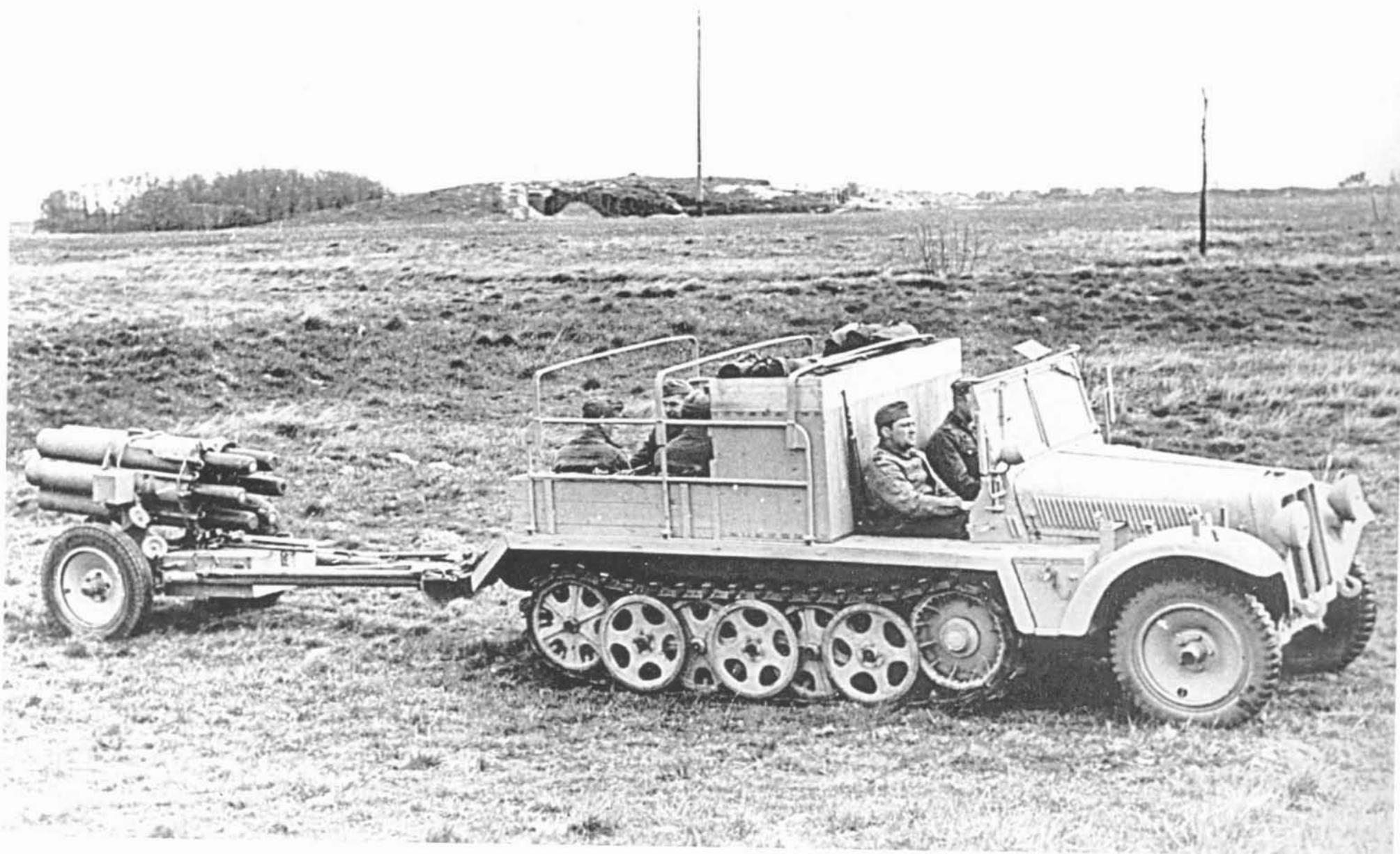
15 cm-Nebelwerfer 41 hinter einem leichten Zugkraftwagen 1 t (Sd. Kfz. II). (BA)
